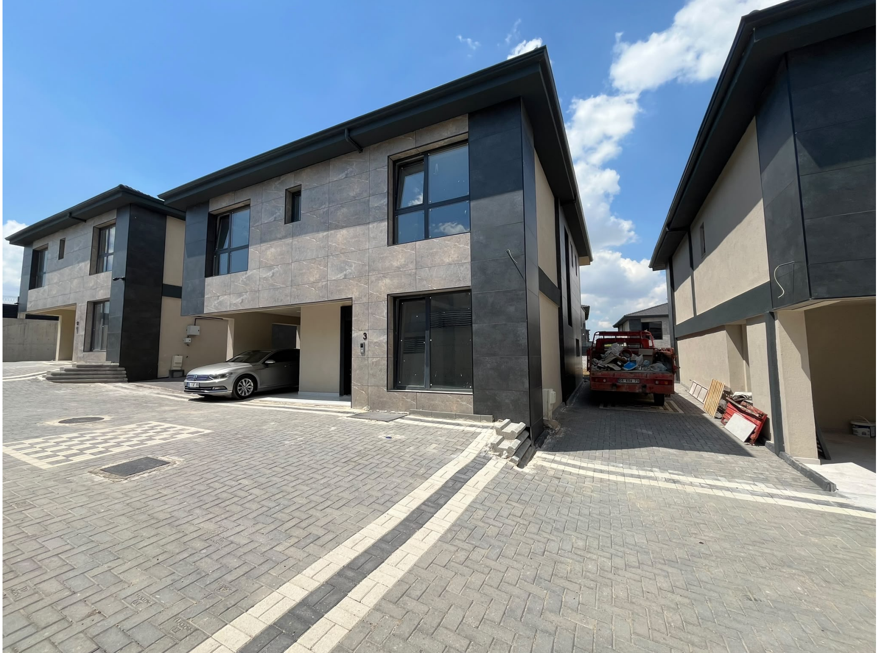
Villa ön cephe
